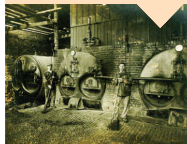
Les chaudières à vapeur au charbon et les générateurs électriques photographiés ici dans les années 1920, occupaient respectivement le rez-de-chaussée et l'étage de la chaufferie de l'usine, devenu désormais espace André Huet.
